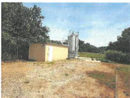
Photo des installations présentes sur le site
